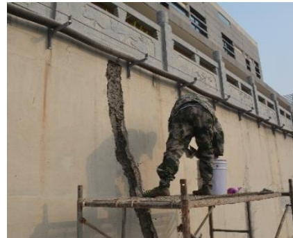
(b) 水闸裂缝修复
